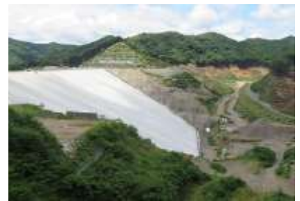
ほぼ完成の南摩ダム
