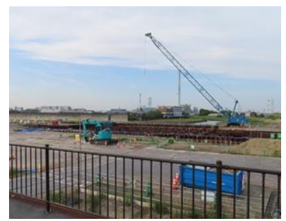
夢の島・新砂水門工事？
