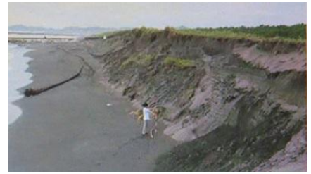
九十九里浜海岸ではこのような浜崖が年間300m～500m程度の速度で、沿岸方向に拡大している
