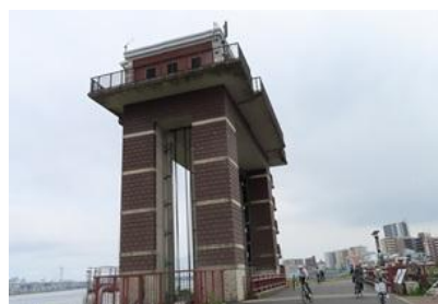
荒川ロックゲート
