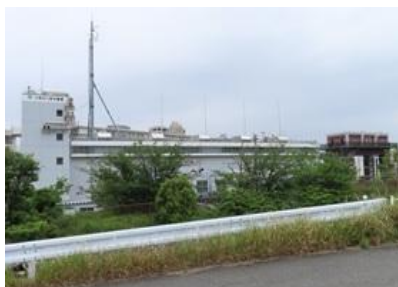
小名木川排水機場
