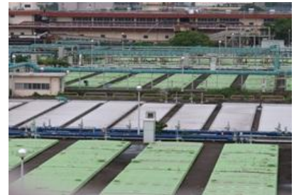
水再生センター・新砂運動場
