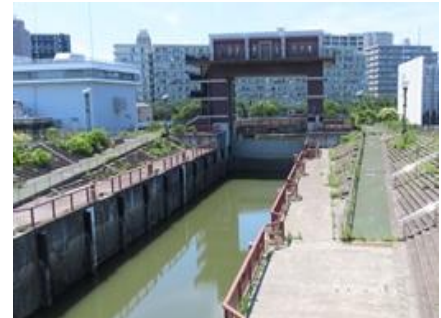
荒川ロックゲート
