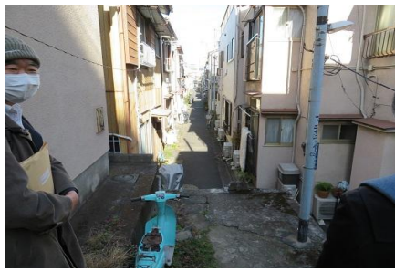
小名木川傍の路道が急に落下していた
