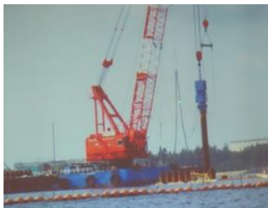
打設クレーン
