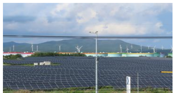
エネルギーパークから風力・太陽光・備蓄タンクを望む
