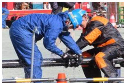
都市ガス本管復旧訓練
